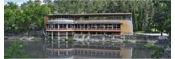
Çubuk Barajındaki Gazino Binası
