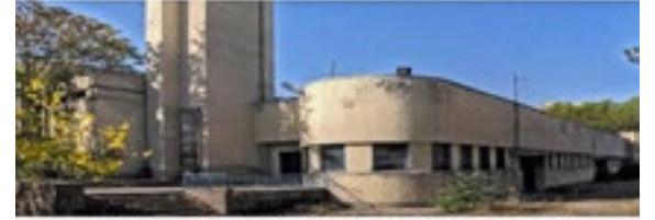
Gümüşdere'deki Su Süzgeci Binası
