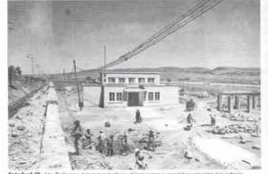
Fotoğraf 48. Atış Poligonu binasının bahçe düzenlenmesi yapılırken Ankara'da inşaat sürecinde. (Fotoğraf: Ömer Merçiy - BYEGM arşivi)
