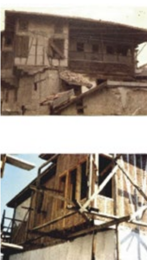
Taç vakfının onardığı 3 yapı restore edilmeden önce ve restorasyon esnasında yapıların durumu (1984-1987)
